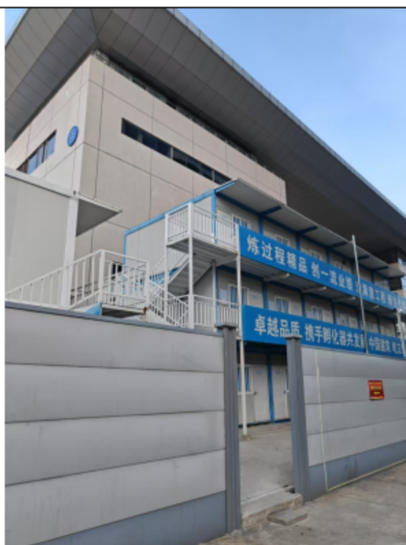
项目南面 中建三局孵化器项目工人生活区
