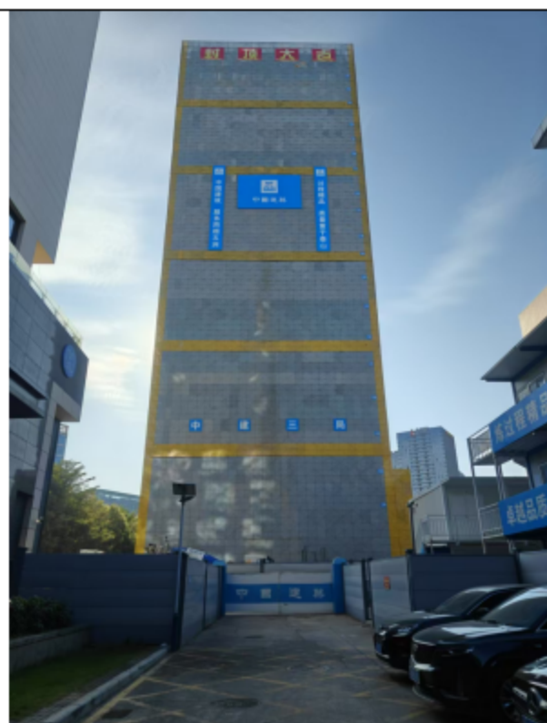
项目所在建筑整体情况 目前在建
