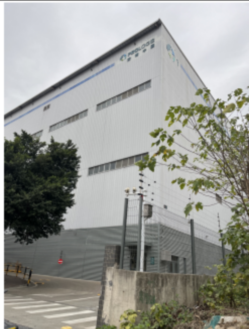
项目西面 安博广州开发区物流中心
